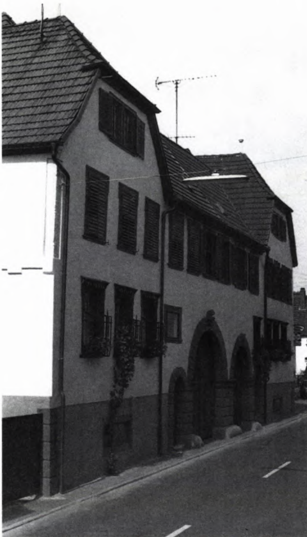
1 BUCHLERSCHES HAUS in Gerlachsheim nach der Instandsetzung.
