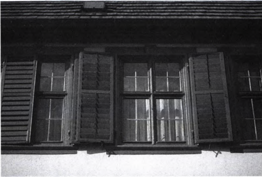
10 DIE REPARIERTEN barocken Kreuzstockfenster bilden wieder eine Einheit mit den alten Klappläden.
