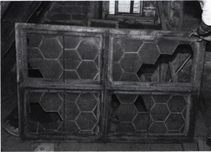
14 BAROCKFENSTER, das sich auf dem Dachboden fand. Es wurde inzwischen wieder eingebaut!
