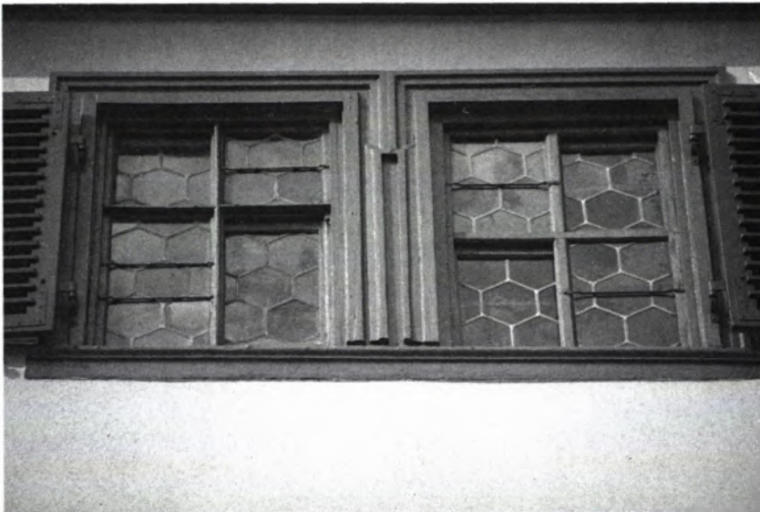
11 DIE SCHIEBEFENSTER im Dachgeschoß waren ohne Scheu unterschiedlich aufgeteilt worden, gleichzeitig mit den Drehflügel Fenstern der „Beletage“.
