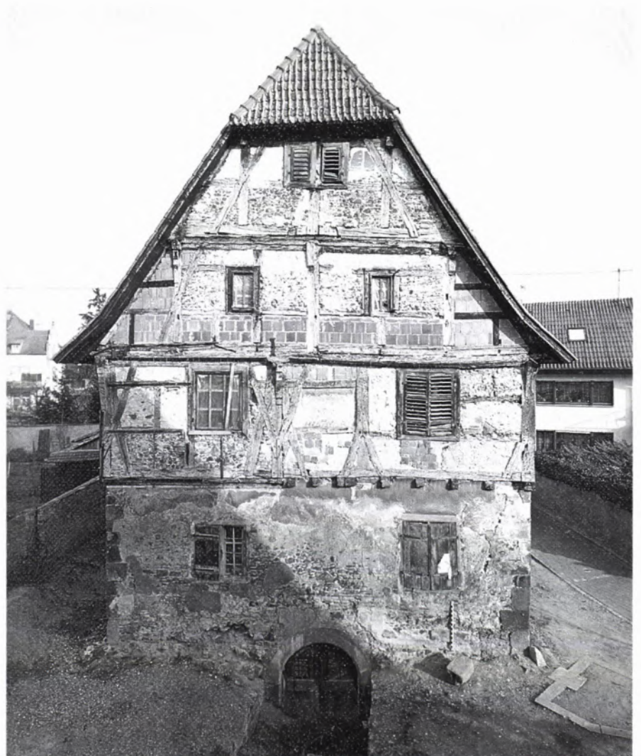
■ 2 Der Üsenberger Hof nach der Dachreparatur in den 1970er Jahren.
