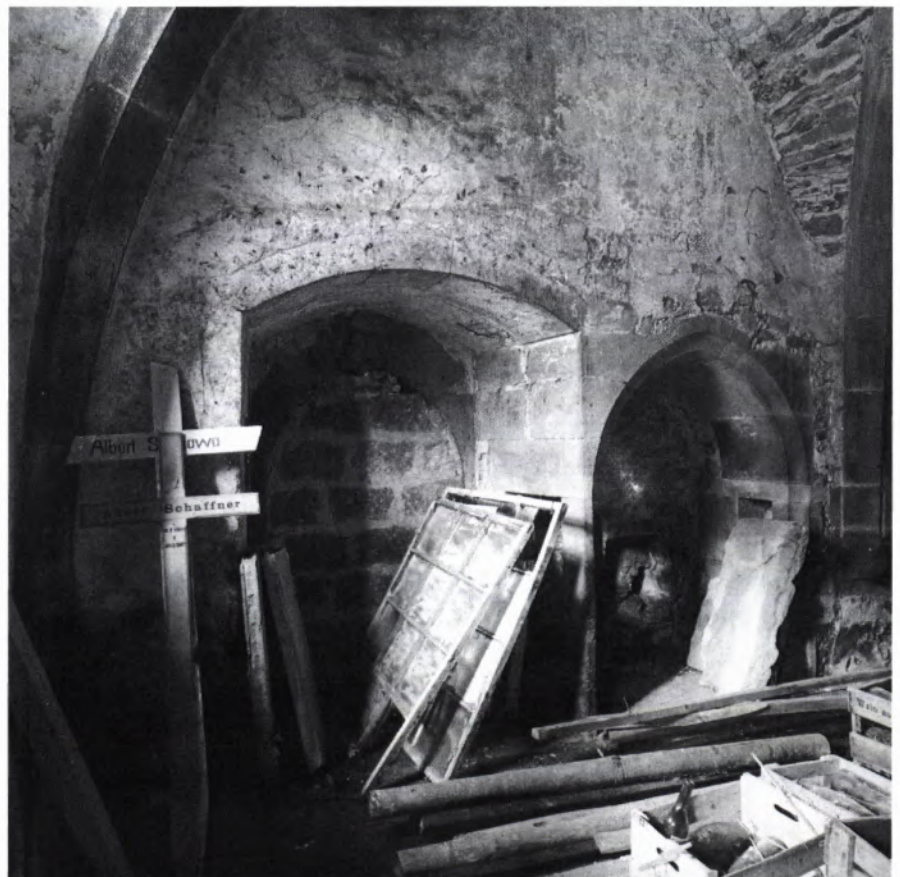
■ 13 Klausur Ostflügel, ehemaliger Zugang zur Kirche in der Nordwand, Mai 1995.
