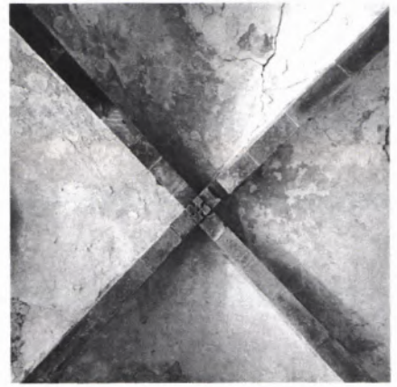
■ 6 Klausur Ostflügel, Sakristei, Detail Gewölbe, südliches Joch, Mai 1995.
