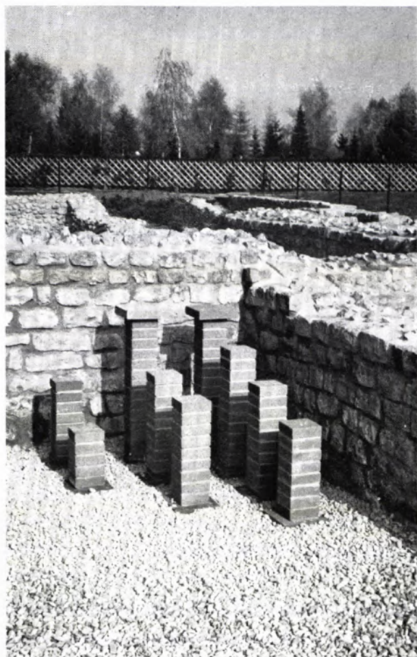
HYPOKAUSTENPFEILERCHEN IN DER NORDOSTECKE DES TEPIDARIUMS. Die kleinen, mit neuen, aber nach alten Maßen geformten Ziegelplatten aufgeschichteten Stützen trugen den begehbaren Fußboden. Dieser wurde erwärmt durch die stark erhitzten Heizgase, die von den Heizräumen aus zwischen die Pfeilerchen strömten.
