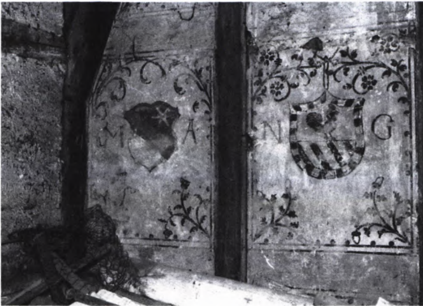
2 WANDMALEREIEN eines im Jahr 1518 gebauten und ausgemalten Rückgebäudes an der Rosgartenstraße – mangels Nutzung offenbar unverändert und unrestauriert erhalten.
