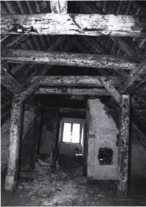
17 GIEBELSTÄNDIGER mittelalterlicher Dachstuhl desselben Hauses.
