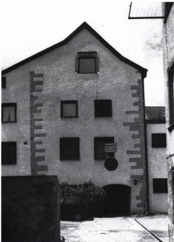
12 ANSICHT EINES „WOHNTURMES“ im hinteren Parzellenbereich an der Rosgartenstraße.
