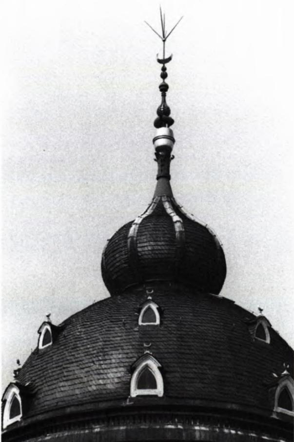
5 SCHWETZINGEN, SCHLOSS. Fünfspitziger Blitzableiter, 1776 errichtet auf dem Dachreiter der Schloßkapelle. An der Wetterstange ist außer einem Kreuz auch noch eine 1726 datierte Windfahne angebracht. Die technischen Details dieser hier gewählten Lösung und Konstruktion hielt der Erfinder Joh. Jak. Hemmer für so grundlegend, daß er sie 1780 mit einer ausführlichen Beschreibung versehen auf einer Abbildungstafel in einem wissenschaftlichen Magazin veröffentlichte (siehe Abb. 1).
