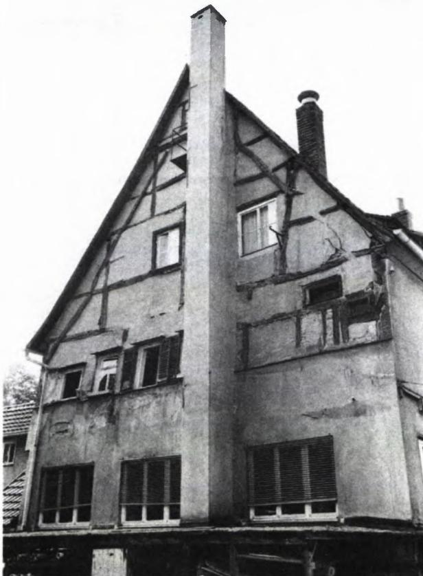
ALS BEISPIEL FÜR DIENENDE STATIK *noch einmal das „Klösterle“ in Stuttgart-Bad Cannstatt (vgl. Nachrichtenblatt Heft 1/86): Vorzustand im August 1976 und vorläufiger Endzustand 1984 der rückwärtigen Giebelseite mit einer Detailaufnahme, die das unverkrampte (ablesbare) Nebeneinander von Altholzern und Ergänzungen zeigt.*
