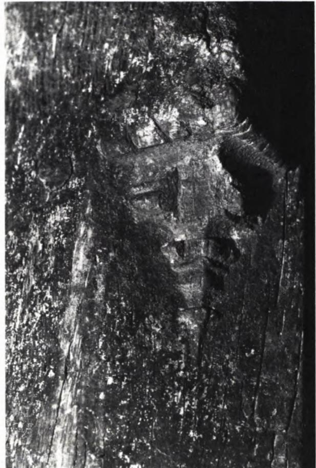
10 DETAIL einer sekundär im Stall des 19. Jahrhunderts eingebauten Holzstütze mit „Tropfenkonsole“. Vermutlich 2. Hälfte 15. Jahrhundert.
