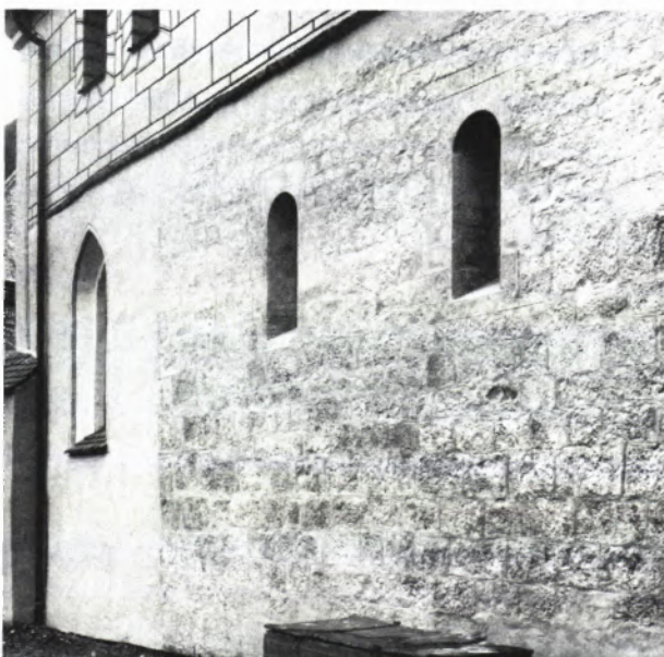
4 ANSATZ der romanischen Apsis in der Verzahnung mit den Quadern des südlichen Triumphbogens.
