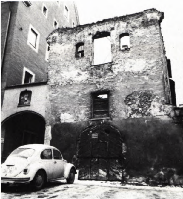
5 OSTWAND des Chores der Nikolauskapelle in ruinösem Zustand (1978).
