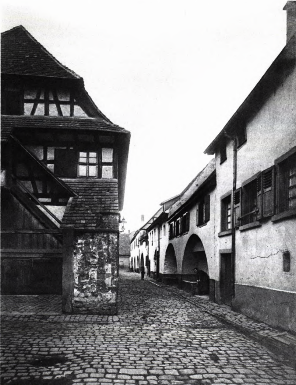
10 BOGENARKADEN der jüngeren Stadtmauer, „An der Stadtmauer“. Links das 1574 errichtete Schlachthaus.
