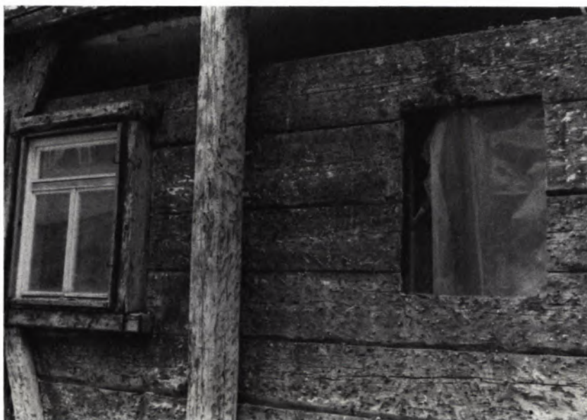
14 ALTENSTEIG, PAULUSSTRASSE 19 (1459 datiert). In Bohlenwand eingeschnittene und gefaßte Fensteröffnungen (1470 datiert).
