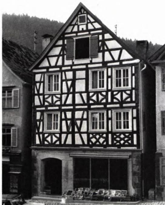
BLUMENHAUS GÖTZ AM SCHILTACHER MARKTPLATZ. Links der Zustand 1956 vor, rechts 1966 nach der Freilegung des Fachwerks. Die gleichzeitig mit der Wiederherstellung der Fachwerkfassade vorgenommene Verbesserung der Öffnungen im Erdgeschoß trägt spürbar zur Steigerung des optischen Gewinns bei.
