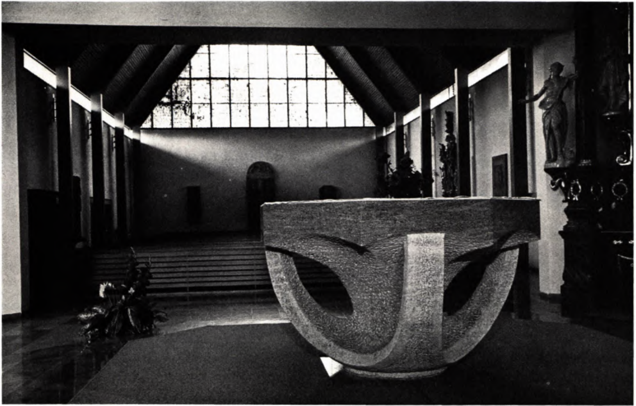
DER NEUE ANBAU VON SÜDEN. Lichtbänder an der Kopfseite der Langwände, vor allem aber die unaufdringlich bunt verglaste Giebelpartie der schließenden Nordwand geben dem Raum eine dezente Ausleuchtung. Sie kommt den vielen mittelalterlichen bis barocken Epitaphen zugute, die aus ihrer störenden Gedrängtheit im Altbau erlöst wurden und hier eine neue Bleibe fanden. Vorne der nach dem Entwurf von Bildhauer Lieb gefertigte neue Zelebrationsaltar.
