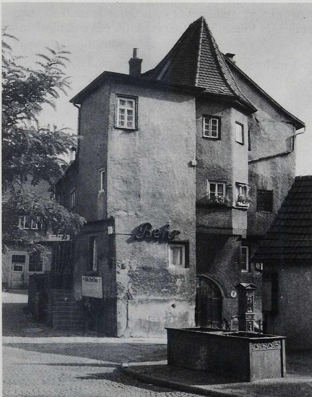
1 DAS „KLÖSTERLE“ 1953 von Norden. Angelehnt an einen Teil der Hofmauer der jüngere dreistöckige Anbau.
