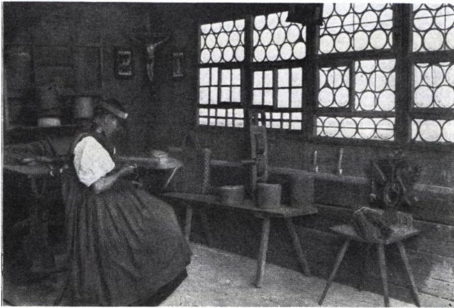
2 SCHIEBEFENSTER eines Schwarzwaldhofes mit verschiedenartiger Verglasung: holzsprossiertes Flachglas und Mondscheibenverglasung. Aufnahme um 1900.
