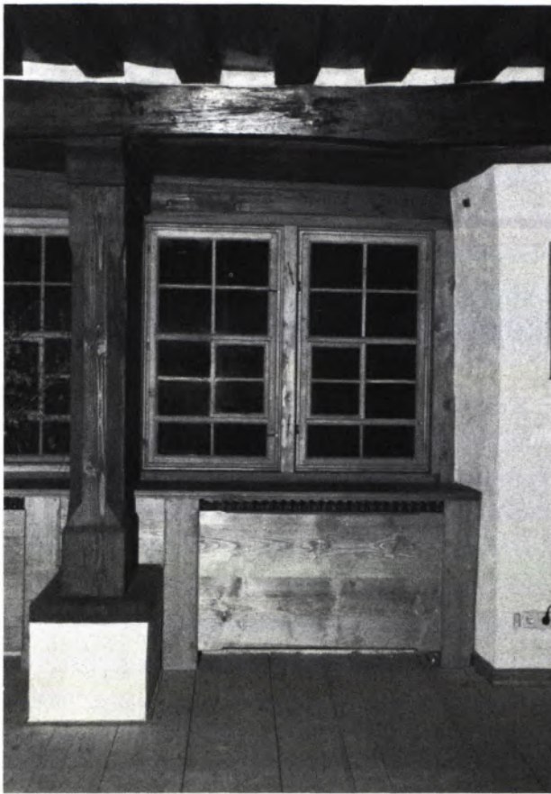
23 NACHBAU alter Schiebefenster in der restaurierten Wohnstube des Hauses Lorenzgasse 3 in Rottweil.
