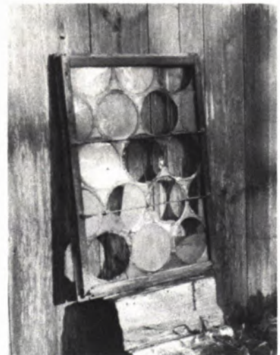
15 und 16 SECHSECK- UND MONDSCHEIBENVERGLASUNG. Die beiden Fenster aus Rottweil haben noch die alte Bleiverglasung.
