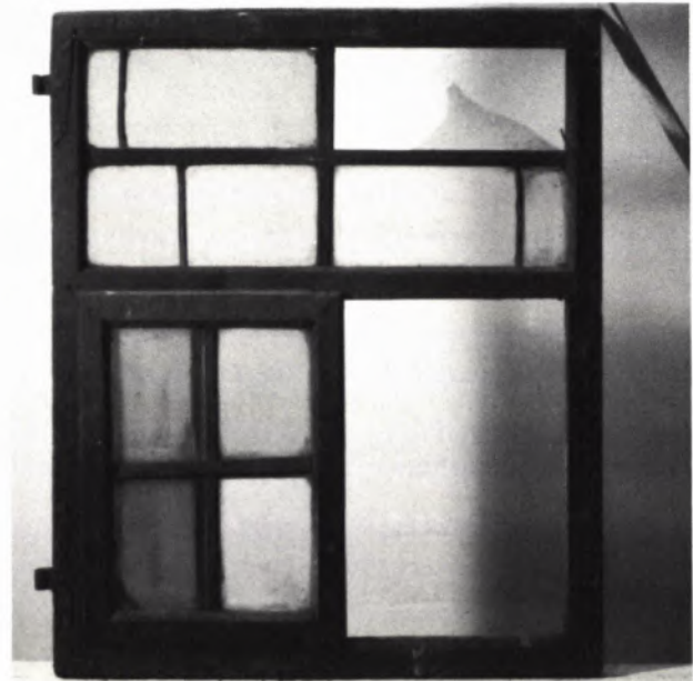
9 SCHIEBEFENSTER in Nürtingen. Dreizonig mit zwei Schiebern oben und unten, Mondscheiben- und Rechteck-Verglasung, vielleicht 17. Jh.
