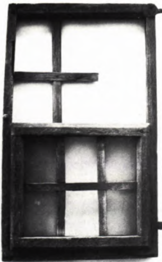
8 ZUM DREHFLÜGEL nachträglich umgebautes Vertikal-Schiebefenster (Innenseite) mit sehr plumper Sprossenteilung, aus Markgröningen, wohl 16. Jh.
