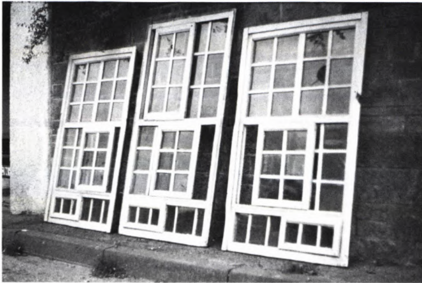
11 SCHIEBEFENSTERGRUPPE (Innenseite) aus der ehem. Badestube im Kloster Hirsau. Die Fenster waren bis vor kurzem noch in Benutzung! Dreizoniger Aufbau, Rechteckverglasung in Eichenrahmen, Häufung der Schiebeteile, 17. Jh. oder älter.
