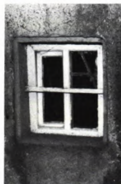
3 KELLERFENSTER, Schiebefenster, nachträglich eingesetzt anstelle eines ursprünglichen Steinschiebers. Es befindet sich am sog. Senftschlößchen, Hauptstr. 22, in Untermünkheim, Kr. Schwäbisch Hall.
