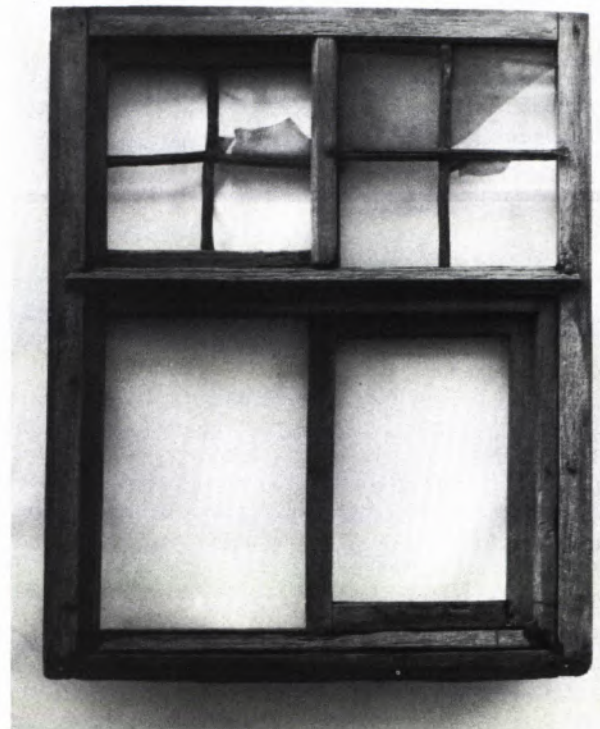
18 FENSTER AUS DER BAROCKZEIT mit zwei Schiebern, davon einer im Drehflügel, dessen Sprossierung verloren ist (Außenseite). Ebenfalls Haus Finstere Gasse 4.
