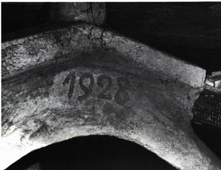
18 DER SCHEITELTEIL der betonummantelten Eisenkonstruktion über dem Gewölbe in Achse 3 von 1928.
