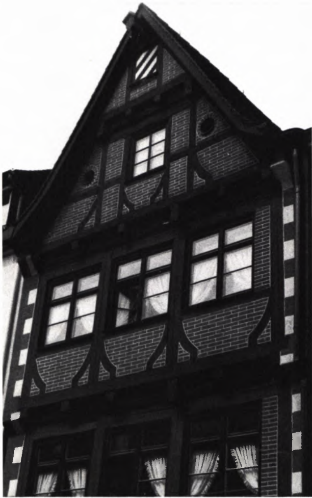
4 ULM, DREIKÖNIGASSE 8. Fassade mit wiederhergestellter Ziegelbemalung.
