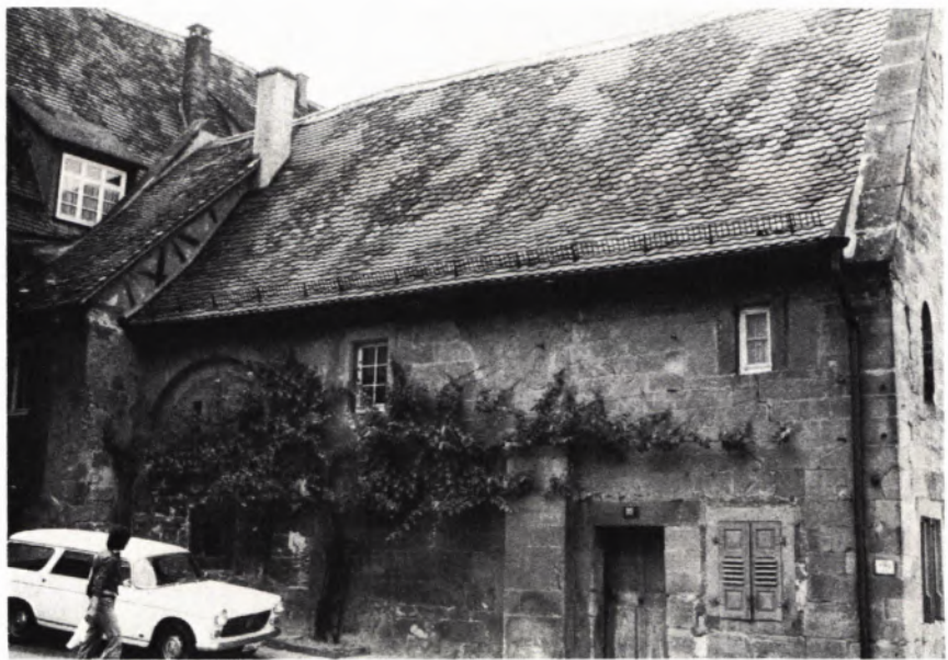
3 SÜDSEITE des Frühmesserhauses vor dem Umbau. Links der zugemauerte Bogen des ehem. inneren Klosters, rechts der Eingang zu den Wohnungen.
