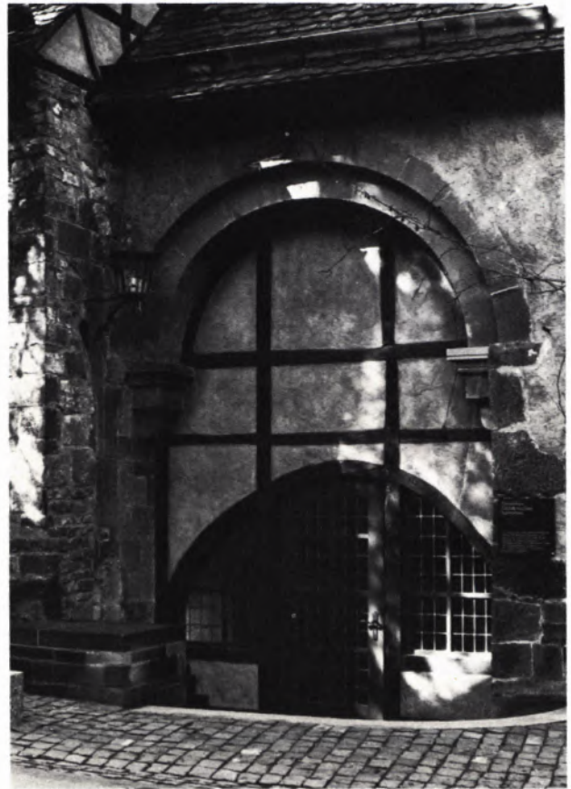
9 DER NEUE MUSEUMSEINGANG. Links und rechts des Bogens sind die Ansätze der ehem. Arkaden zum Klostertor sichtbar.
