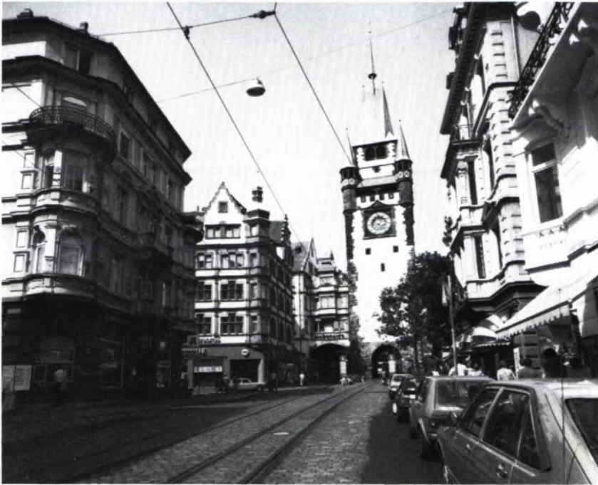
6 MARTINSTOR mit Bekrönung und Nachbarbebauung von Karl Schäfer. Beispiel für die weitgehende Neugestaltung der Altstadt um die Jahrhundertwende.
