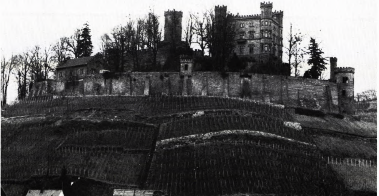
1 GESAMTANSICHT VON SÜDWESTEN.
