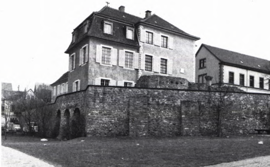
5 BISCHOFSHOF von Südwesten mit Resten des Befestigungssystems. Hier wird zudem die exponierte Lage auf dem Hochufer sichtbar.
