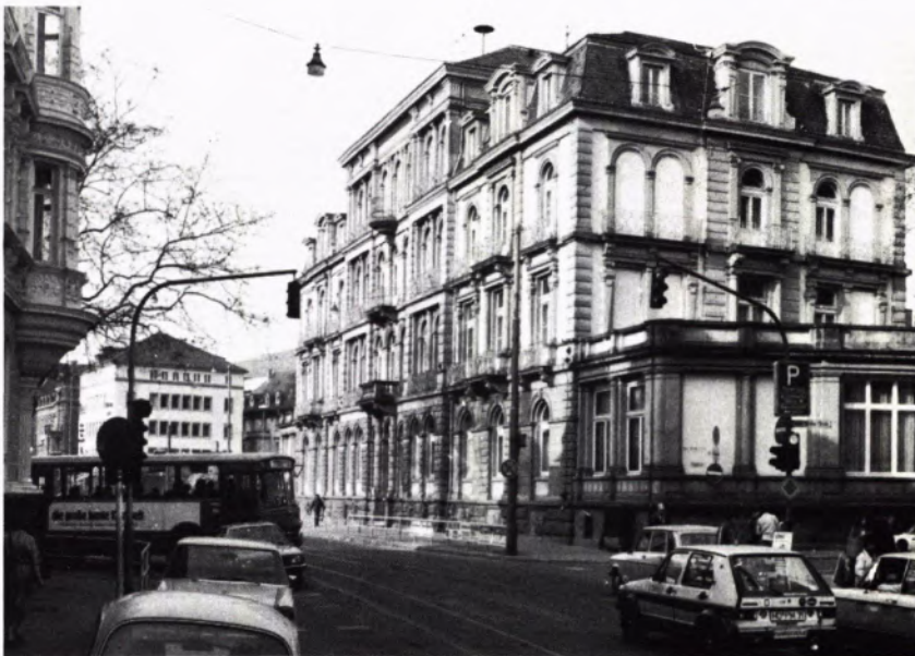
7 EHEMALIGES GRAND-HOTEL (heute Polizeidirektion), erbaut 1876/77 an der Rohrbacher Straße.
