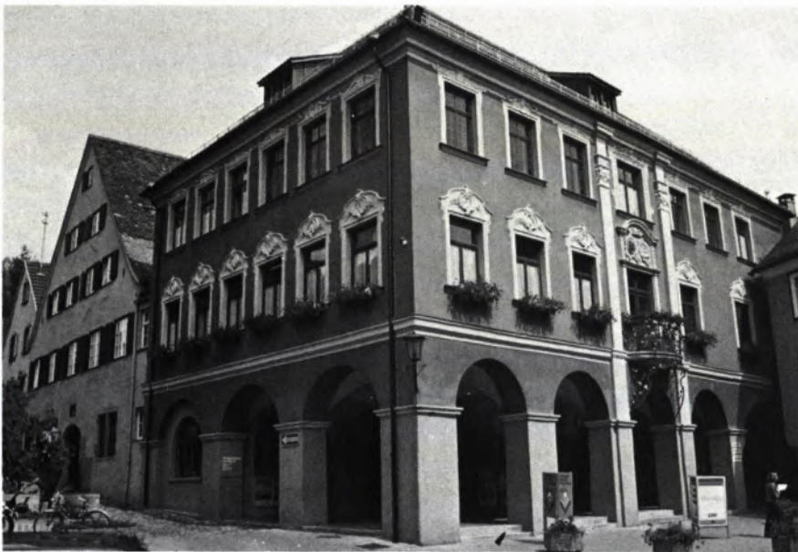
5 DAS RATHAUS, links daneben die ehemalige Kanzlei.
