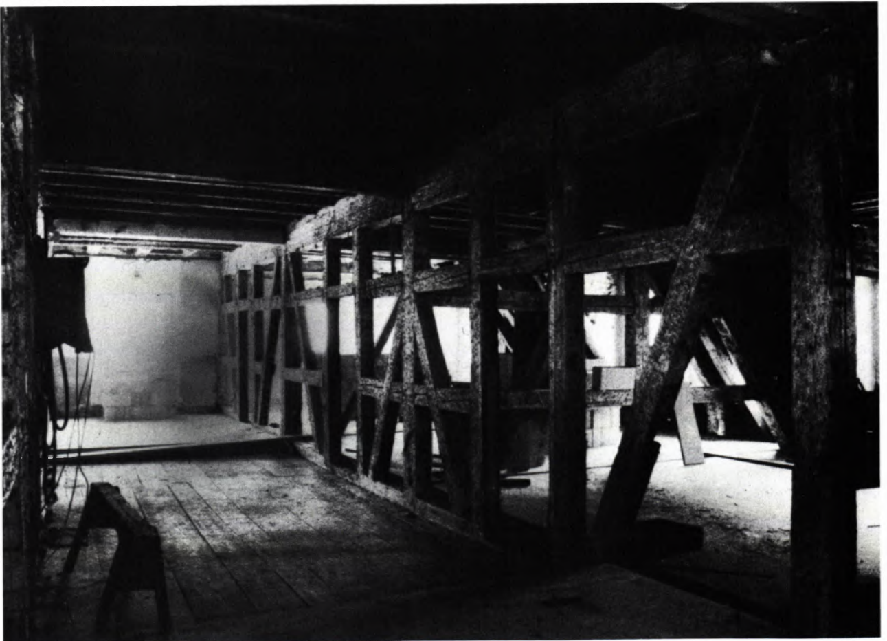
4 BAD ÜBERKINGEN. AUSGELEERTES FACHWERK im Mittelflur des Dachgeschosses im Badhotel.
