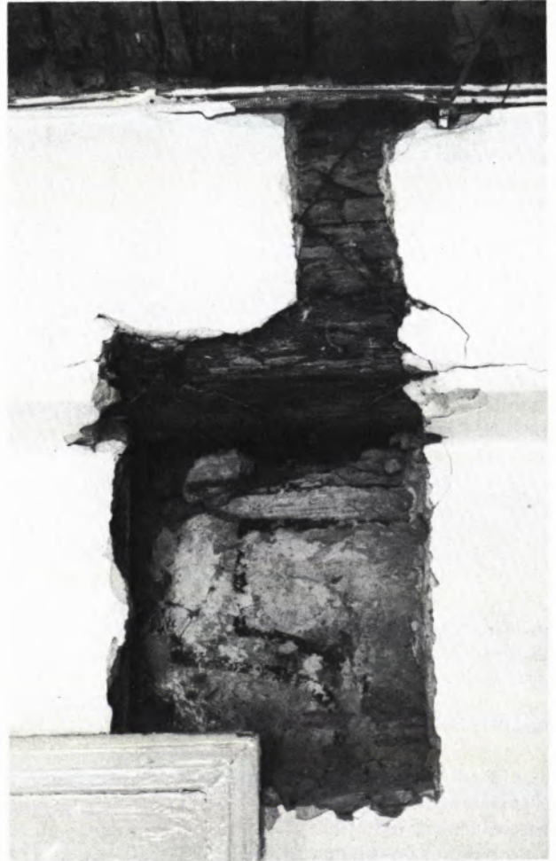
14 EHEM. OBERAMTSGEBÄUDE. Graue und schwarze Begleitstrichmalerei kam unter dicken Putzschichten zum Vorschein.
