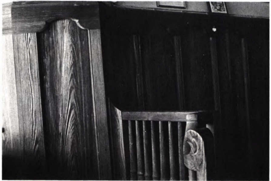
10 EHEM. HERRENZIMMER des Lindenhofs im ersten Oberge- schoß: Detail der Täfelung.
