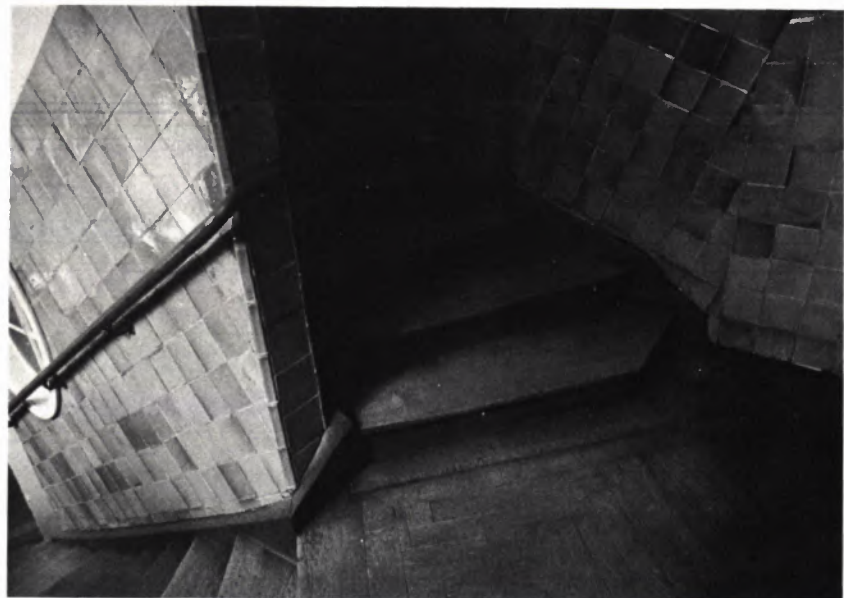
4 TREPPENHAUS zwischen erstem und zweitem Obergeschoß.
