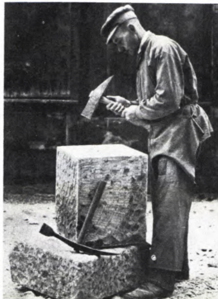
4 STEINMETZ bei der Steinbearbeitung. Links: Das Scharrieren. Rechts: Das Abflächen mit der Spitzfläche. Das kleinere Werkzeug hat die ältere Form.
