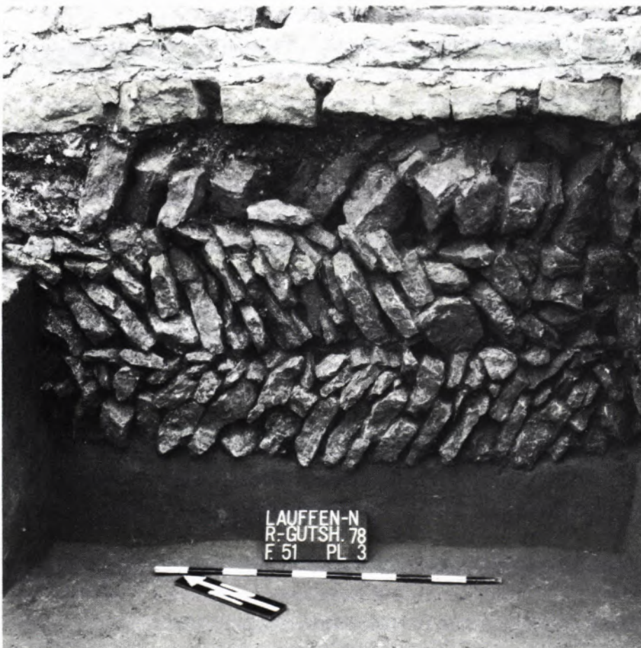
5 FUNDAMENT mit sorgfältig gesetzter Rollierung im südlichen Eckrisaliten des jüngeren römi- schen Wohnhauses.
