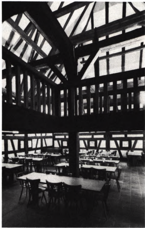
6 SPEISESAAL IM ERDGESCHOSS mit Blick in den Dachraum.
