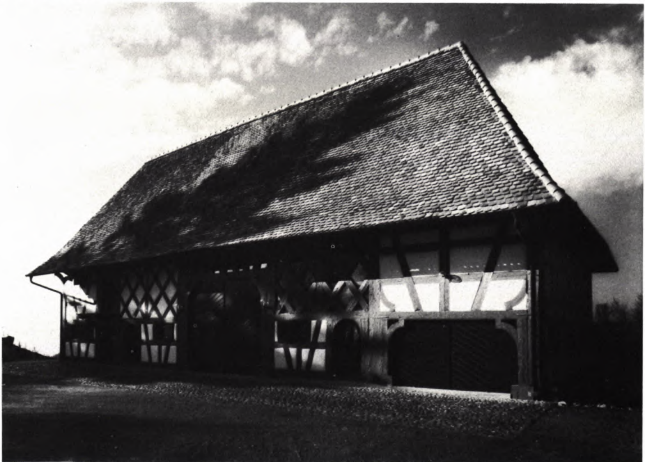
1 HOHENFELS. EHEMALIGE ZEHNTSCHEUNE, die heute ein Schülerhaus beherbergt. Blick auf die Eingangsseite im Osten.
