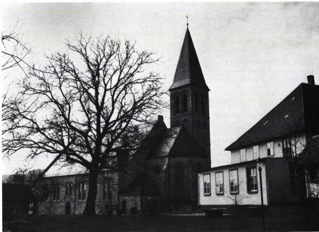
1 ANSICHT DER PFARRKIRCHE ST. LEONHARD VON NORDOSTEN. Als neueste historische Schicht ist an der Chorschräge unter einem Pultdach der Ölberg erkennbar, der 1977 angebaut wurde.
