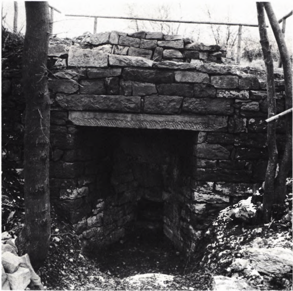
5 ANSICHT DES WIEDERHERGESTELLTEN FAHRKALKOFENS von Westen mit Feuerloch, aus dem auch der gebrannte Kalk ausgezogen wurde, sowie Unterstand für die Befuerung während des Brennvorgangs. Oberteil mit Sturz ergänzt.
