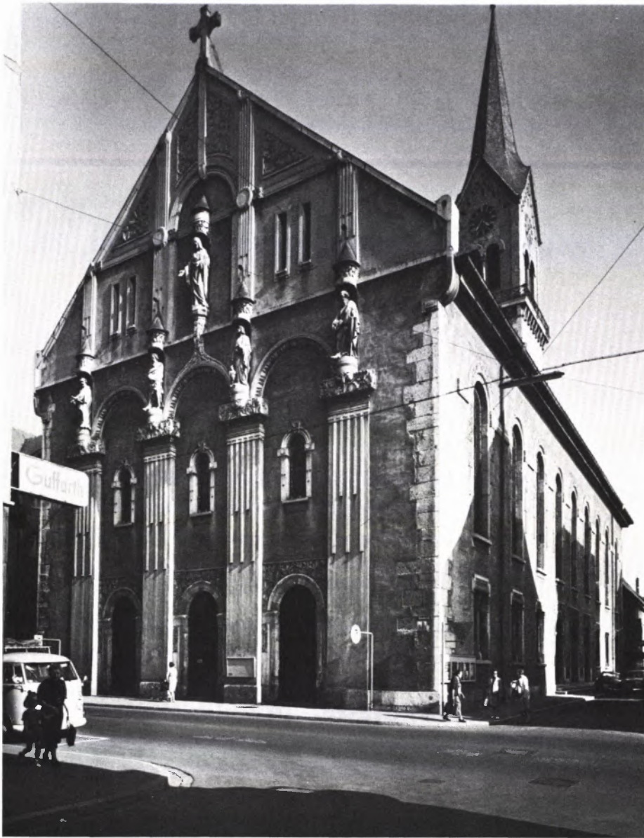
7 DIE TUTTLINGER KIRCHE von Norden vor der Restaurierung. Der alte Kammputz ist völlig verschmutzt, und die ständig aufs neue durchfeuchteten Mauer- teile zeichnen sich durch Ausblühungen ab. Die Zementprofile lie- ßen ihren schadhafte Zustand weniger optisch als vielmehr durch immer wieder herabfallende Teile erkennbar werden. Aber erst vom Gerüst aus zeigten sich die Schä- den in ihrem wahren Ausmaß.
