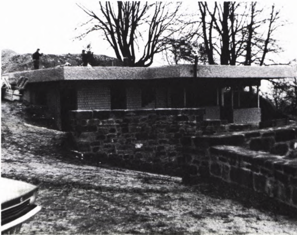
4 DER ROHBAU DER „SCHUTZHÜTTE“, die nach Auskunft der Stadt Göppingen durch Begrünung „so unsichtbar wie möglich“ gemacht werden soll (Stuttgarter Zeitung Nr. 243, 1976, S. 6). Zustand am 1. Dezember 1976.
