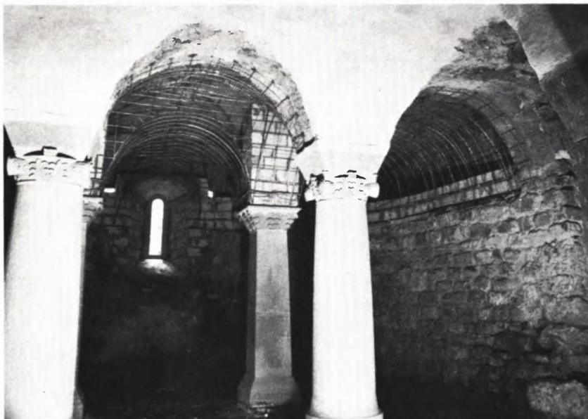
5 ÜBER NACHGEARBEITETEN STÜTZEN wurde der Gewölbeverlauf im Apsisbereich durch eine Metallkonstruktion vorgeformt.
