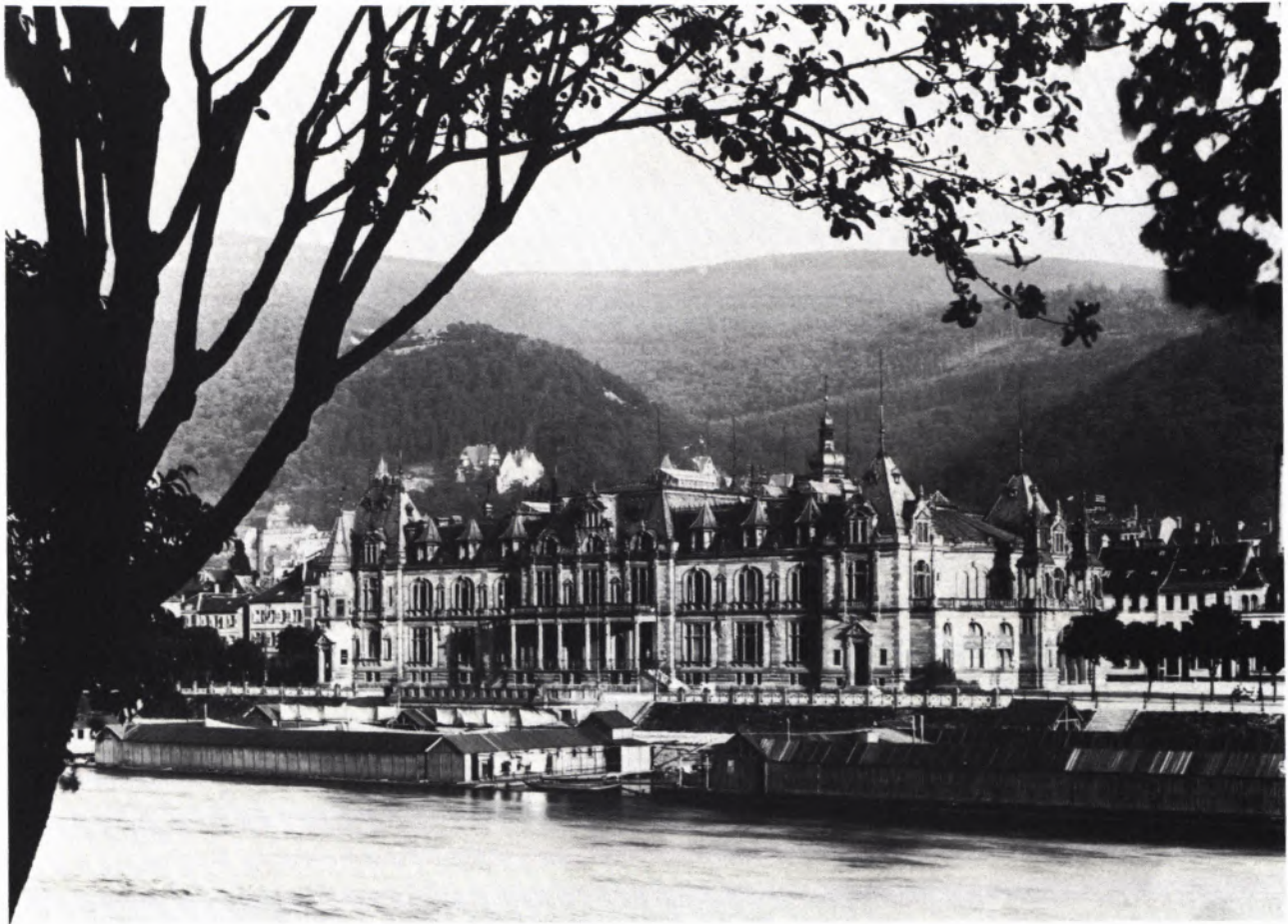
3 DIE STADTHALLE AM NECKARSTADEN, errichtet 1903 von Henkenhaf und Ebert in der für Heidelberg typischen Stilrichtung der Neo-Renaissance, wurde neben dem mittelalterlichen Marstall und der Alten Brücke zu einem Hauptakzent der Neckarfront. Die bald nach der Einweihung entstandene Aufnahme zeigt die ursprüngliche Gestaltung der Uferzone und die in den 1870er Jahren angelegte Uferstraße, die als breite, baumbestandene Promenade die Alte Brücke mit der 1874/75 neu errichteten Neckarbrücke verband. Die letzten Reste dieses von stattlichen Wohnbauten im Westen gesäumten Boulevards sind durch den Ausbau zur Umgehungsstraße für den Fernverkehr bedroht, wenn sich nicht rechtzeitig die Tunnellösung als die einzige dem Heidelberger Stadtbild angemessene Trassenführung durchsetzt.
