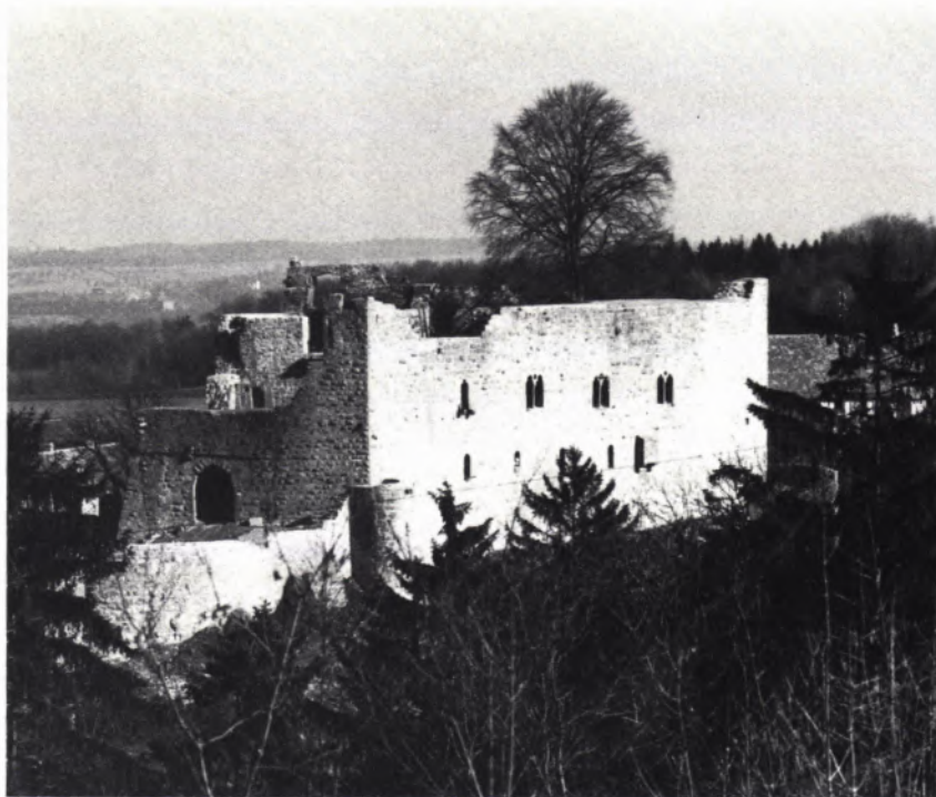
BURG LEOFELS nach der Sanierung.
