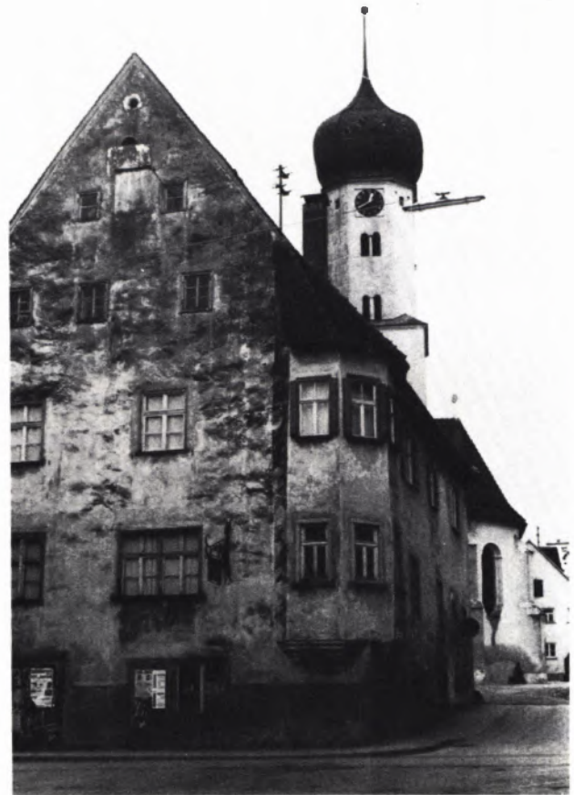
NERESHEIM. Vogtshaus vor der Sanierung.
