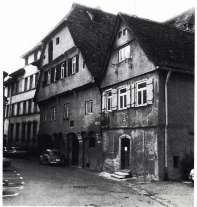
GEISLINGEN. Schubarthaus vor der Sanierung.
