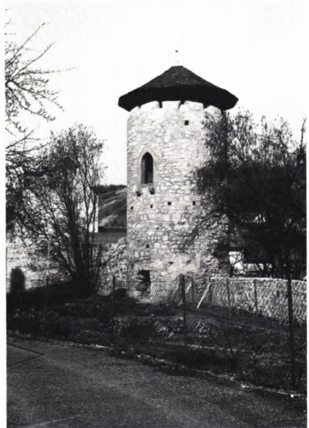
NIEDERSTETTEN. Fuchsturm nach der Instandsetzung.
