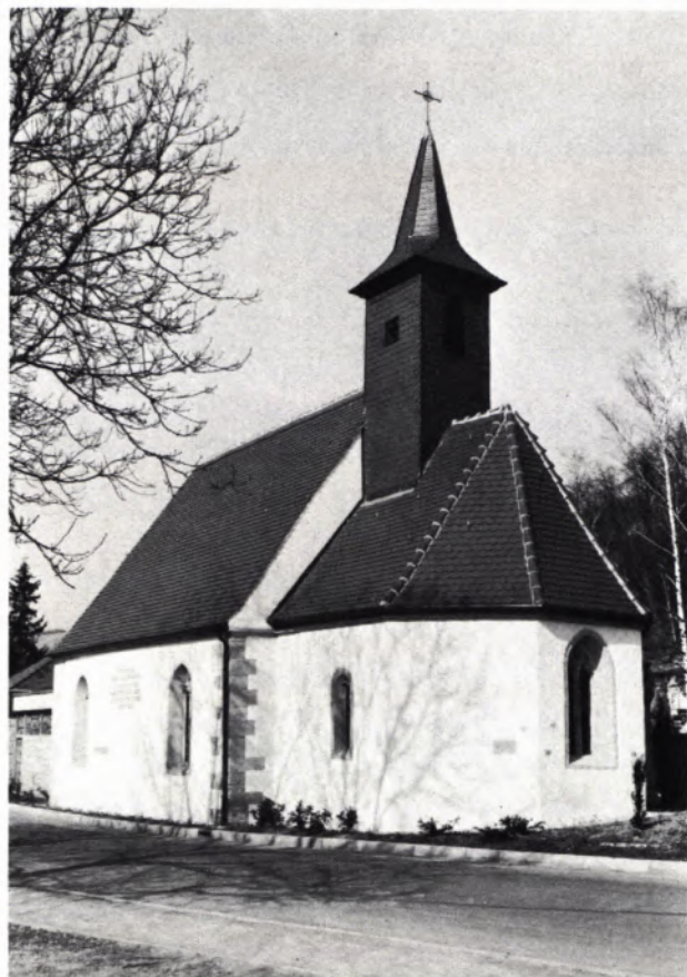
INGELFINGEN. St.-Anna-Kapelle nach der Renovierung.
