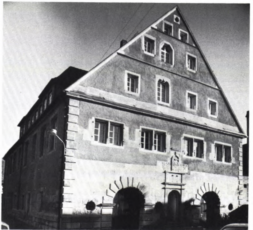
SCHWÄBISCH GMÜND. Schmalzgrube. Die Fassade nach der Restaurierung. ▶
