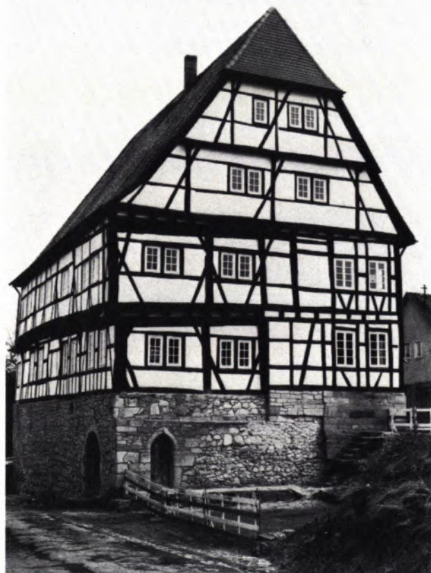
KORNWESTHEIM. Schafhof nach der Sanierung.
