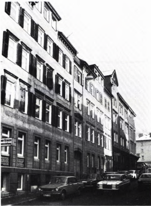
3 DIE ROSENSTRASSE, ein typischer Straßenzug aus der Mitte des 19. Jahrhunderts mit Mietshäusern. Verputztes Fachwerk über Natursteinsockel.
