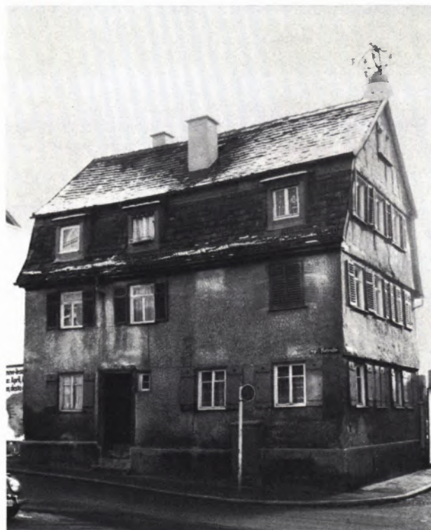
6 ZU DEN ÄLTESTEN GEBÄUDEN im Bohnenviertel gehört dieses frühbarocke Fachwerkhaus mit Mansarddach an der Ecke Rosen- und Weberstraße. Mit seiner rückwärtigen Giebelseite sitzt es auf der alten Stadtmauer auf. Leider ist der bauliche Zustand des Gebäudes so schlecht, daß es nur mit sehr großem Einsatz gerettet werden kann.
