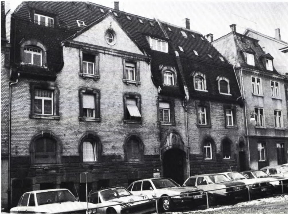
12 WEBER-STRASSE 49/51. Neben dem Materialwechsel von Rustika und Backstein sind an diesem Gebäude die Hochparterre-Lösung beachtenswert sowie die Asymmetrie der Fenster- und Türachsen und die sorgsame Durchgestaltung der Fenster-einfassungen.
