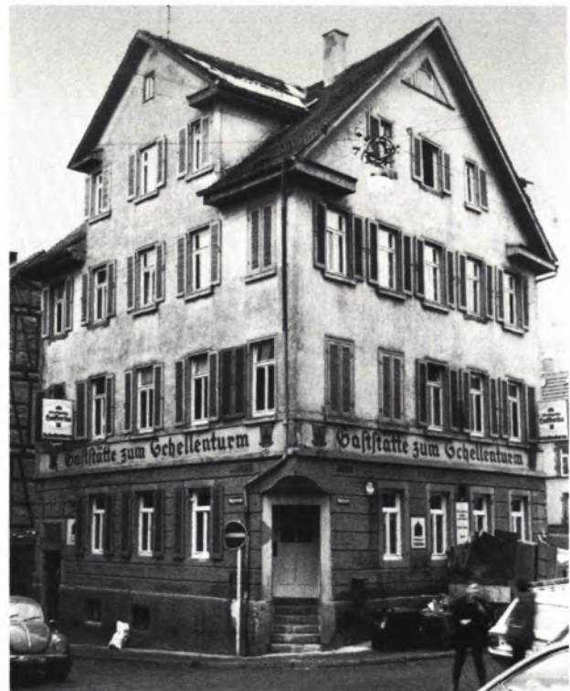
7 KLASSIZISTISCHES GEBÄUDE mit Zwerchgiebel aus der ersten Hälfte des 19. Jahrhunderts. Das Bauwerk wird durch den wohl erst nachträglich über Eck gestellten Eingang und eine rustizierte Erdgeschoßzone belebt. Die „Wiederkehr“ am Fuß der Giebeldreiecke, die Geradlinigkeit und die damit verbundene Klarheit und Strenge der Gliederung sind typisch für diese Bauepoche.
