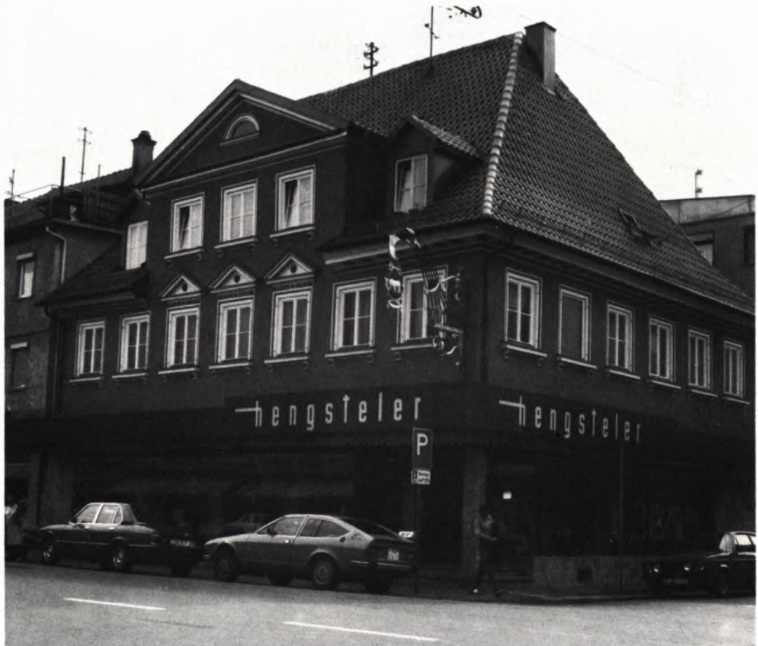
5 „VERSCHÖNERUNG“ DES STADTBILDES: das von der Stadt Balingen prämierte Gebäude Friedrichstraße 28. Oben ansprechend, unten durch Vordach mit „Bauchbinde“ und großen Glasflächen gestaltet.
