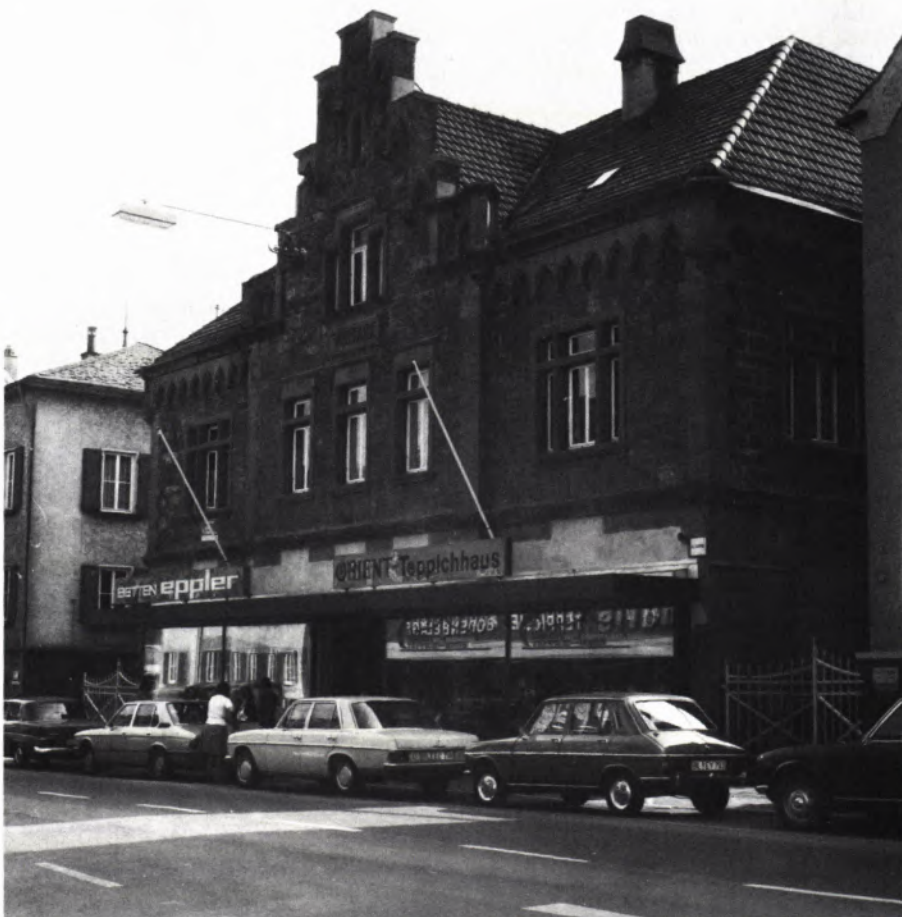
4 NACH DEM ERDGESCHOSSUMBAU, der 1976/77 am ehemaligen Postamt in Balingen vorgenommen wurde und den das Stadtbauamt als „funktionsgerecht, städtebaulich und gestalterisch befriedigend“ bezeichnet.
