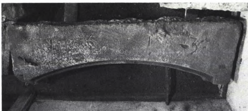
1 TÜRSTURZ VOM MÜHLEN- GEBÄUDE der ehemaligen Herrenmühle in Heidelberg. Der Stein trägt die Jahreszahl 1613.
