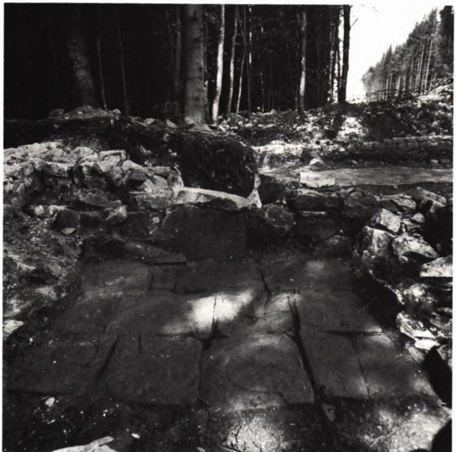
4 DETAIL DES ZIEGEL-PLATTENBODENS in Bau 1 während der Ausgrabung 1977.
