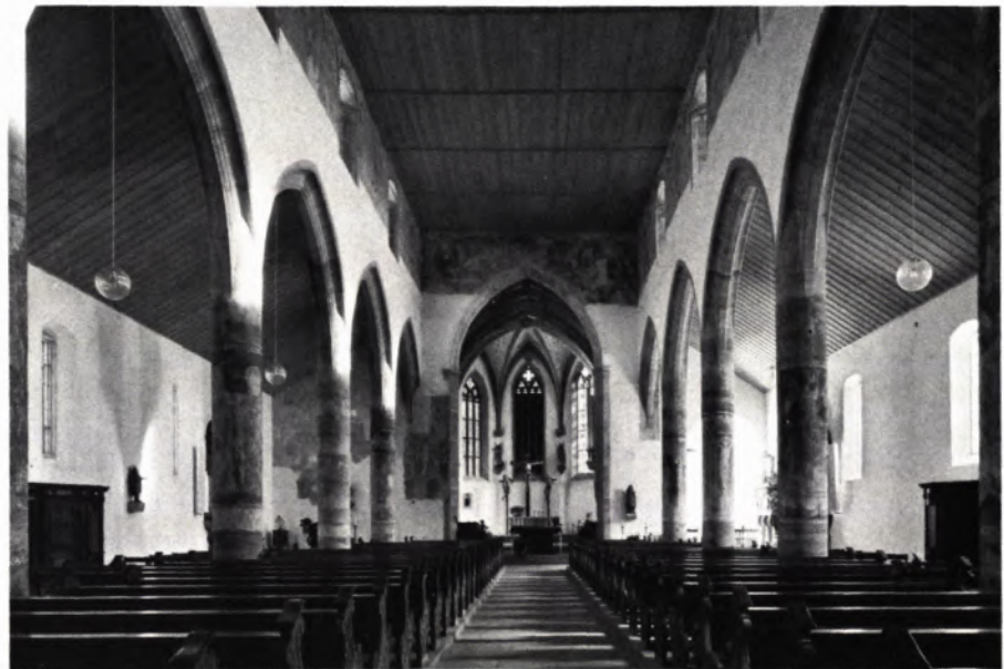
5 und 6 ST. MORITZ in Rottenburg, Kreis Tübingen. Die Instandsetzung von 1969 bis 1975 beseitigte alle barocken Hinzufügungen und versuchte, den Raum des 14./15. Jahrhun- derts „stilrein“ wiederzugewin- nen: Beispiel einer purifizierenden Denkmalpflege mit Gewinn an wissenschaftlicher Erkenntnis (spätgotische Wandmale- reien des Obergadens) und hy- pothetischen Zutaten (z. B. Seitenschiffsfenster, Holz- decken).
