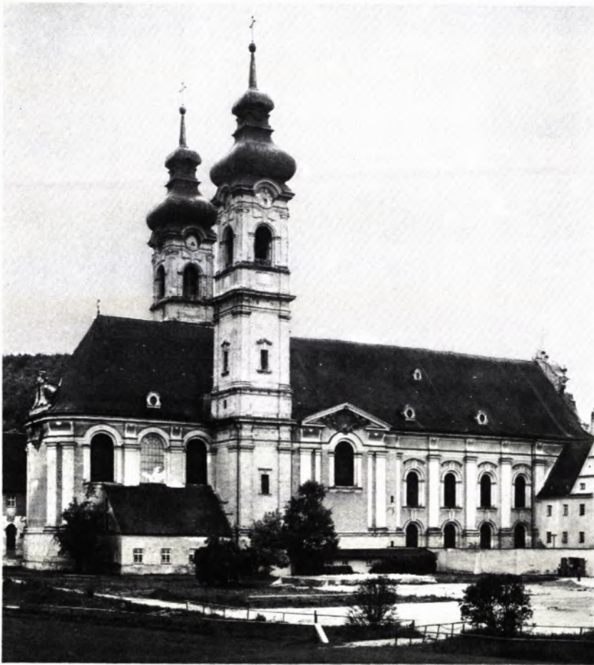
2 KLOSTERKIRCHE ZWIEFALTEN von Nordosten vor der Restaurierung.
