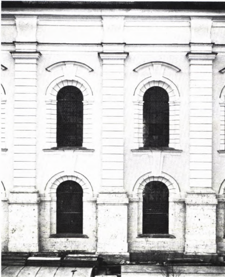
6 AUSSCHNITT AUS DER NORDFAS- SADE DES ZWIEFALTENER MÜNSTERS: Zustand nach der Restaurierung 1975 mit erneuertem Putz, Farbgebung nach Befund und Sockellasur. Die originalen Kupferblech- abdeckungen der Gesimse wurden befund- getreu erneuert.
