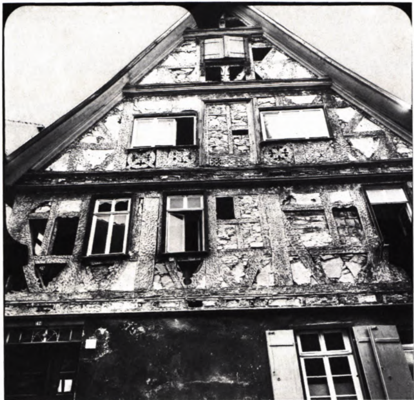
3 DAS SCHMUCKFACHWERK des Alten Schulhauses nach dem Abschlagen des Putzes.
