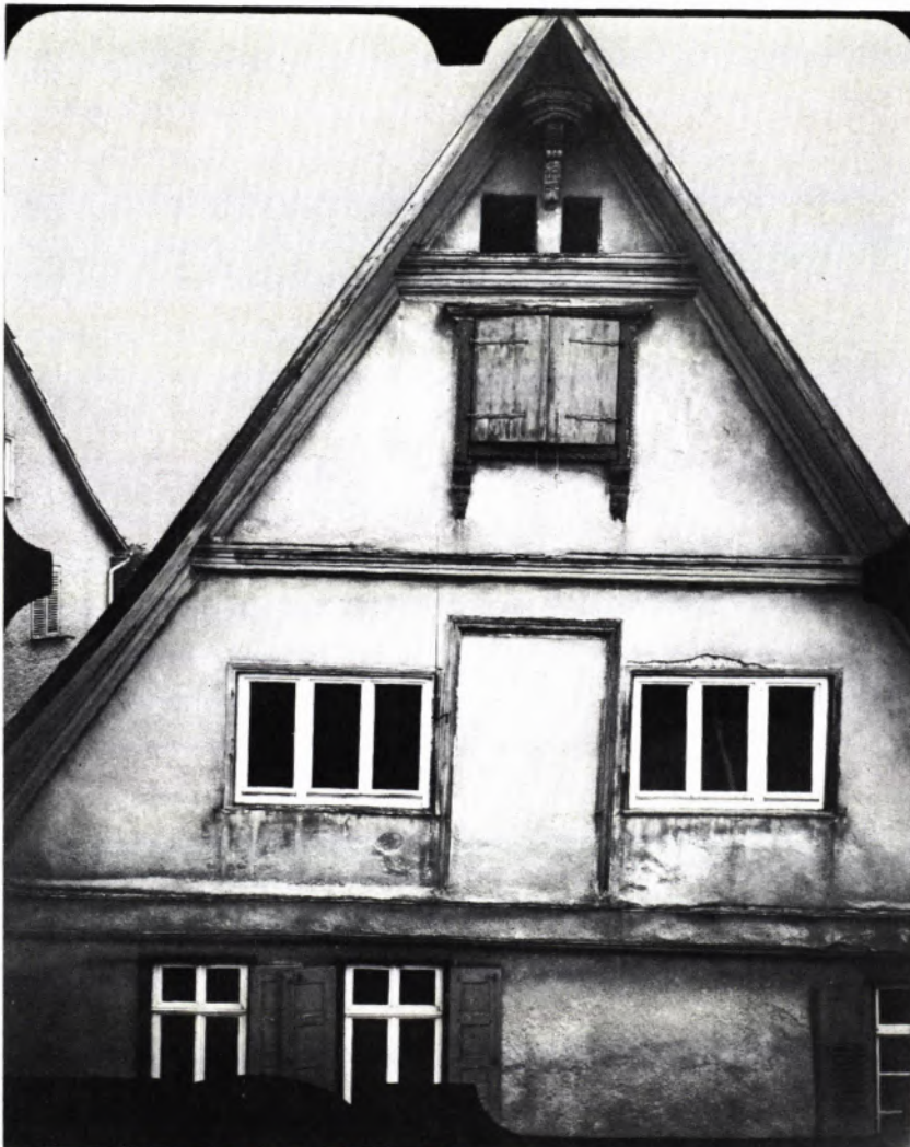
2 DAS ALTE SCHULHAUS in Plochingen. Der verputzte Nordgiebel.
