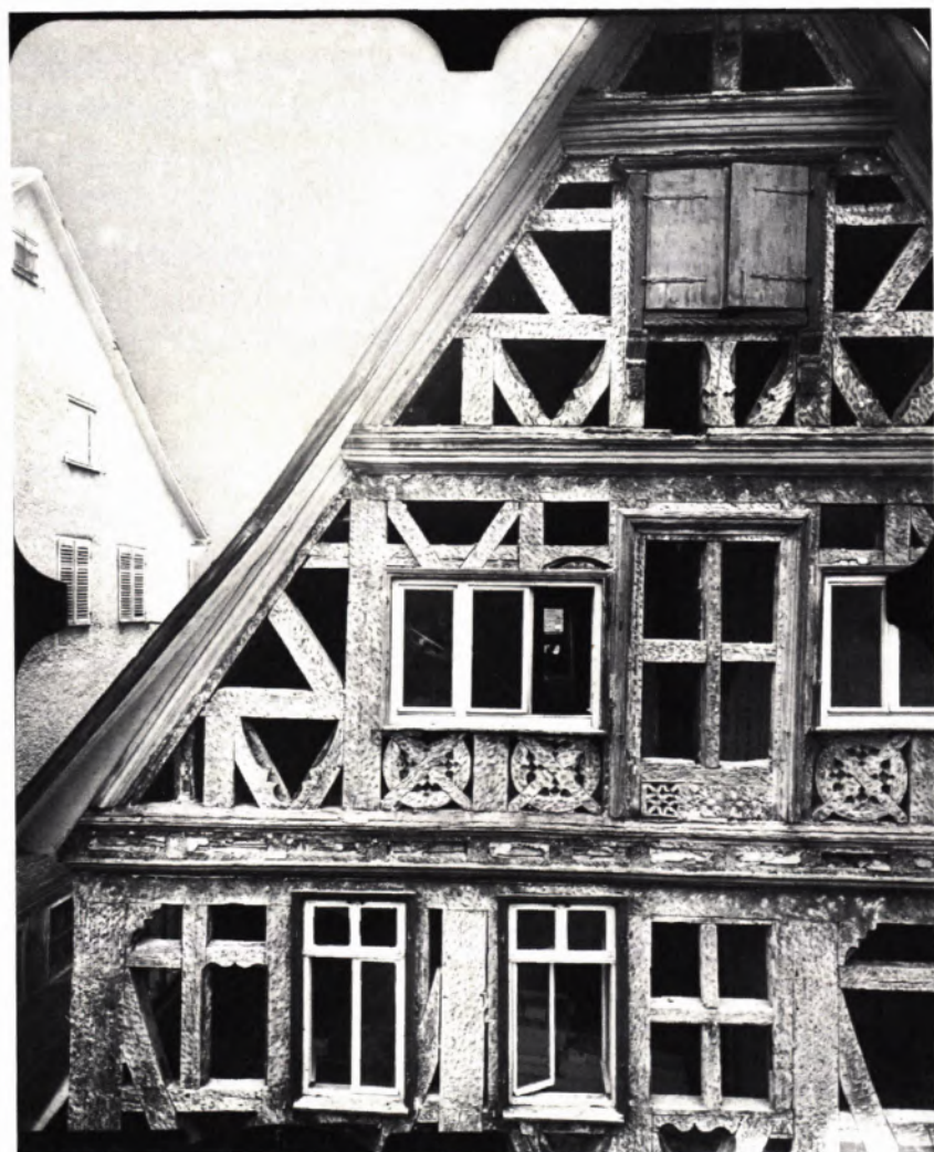
4 DAS FACHWERKSKELETT nach dem Entfernen der Ausriegelung.
