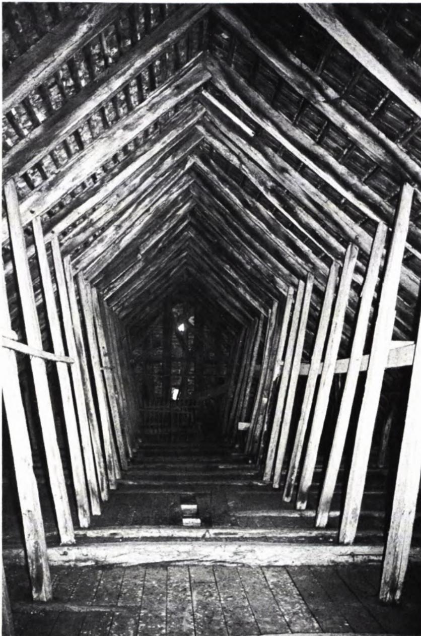
2 KLOSTERKIRCHE BILLIGHEIM. Blick in den Dachstuhl gegen Westen. Erkennbar sind die mit den Sparren und Deckenbalken verblatteten vier Streben je Sparrenpaar.
