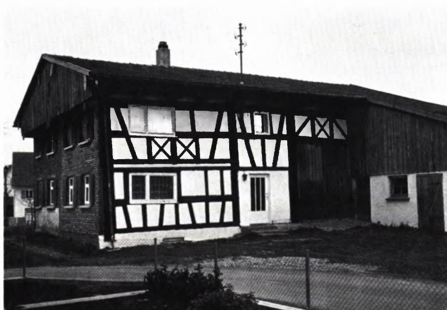
1 und 2 AUSNANG bei Leutkirch im Allgäu, Kreis Ravensburg. Fassade des Hauses Nr. 50 um 1920 und 1969: Verunstaltung eines im Denkmaltbuch eingetragenen Kulturdenkmals durch „Modernisierung“. Alle Anfragen des Landesdenkmalamtes bei der zuständigen Baurechtsbehörde blieben unbeantwortet.
