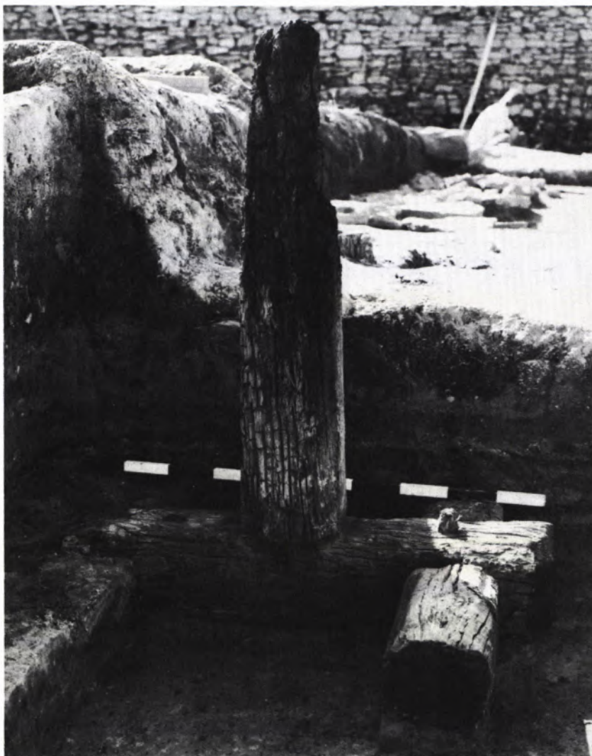
4 AUS DER SIEDLUNG vor Errichtung der ältesten Burg: Beispiel für die Zimmerungstechnik der Holzbauten.
