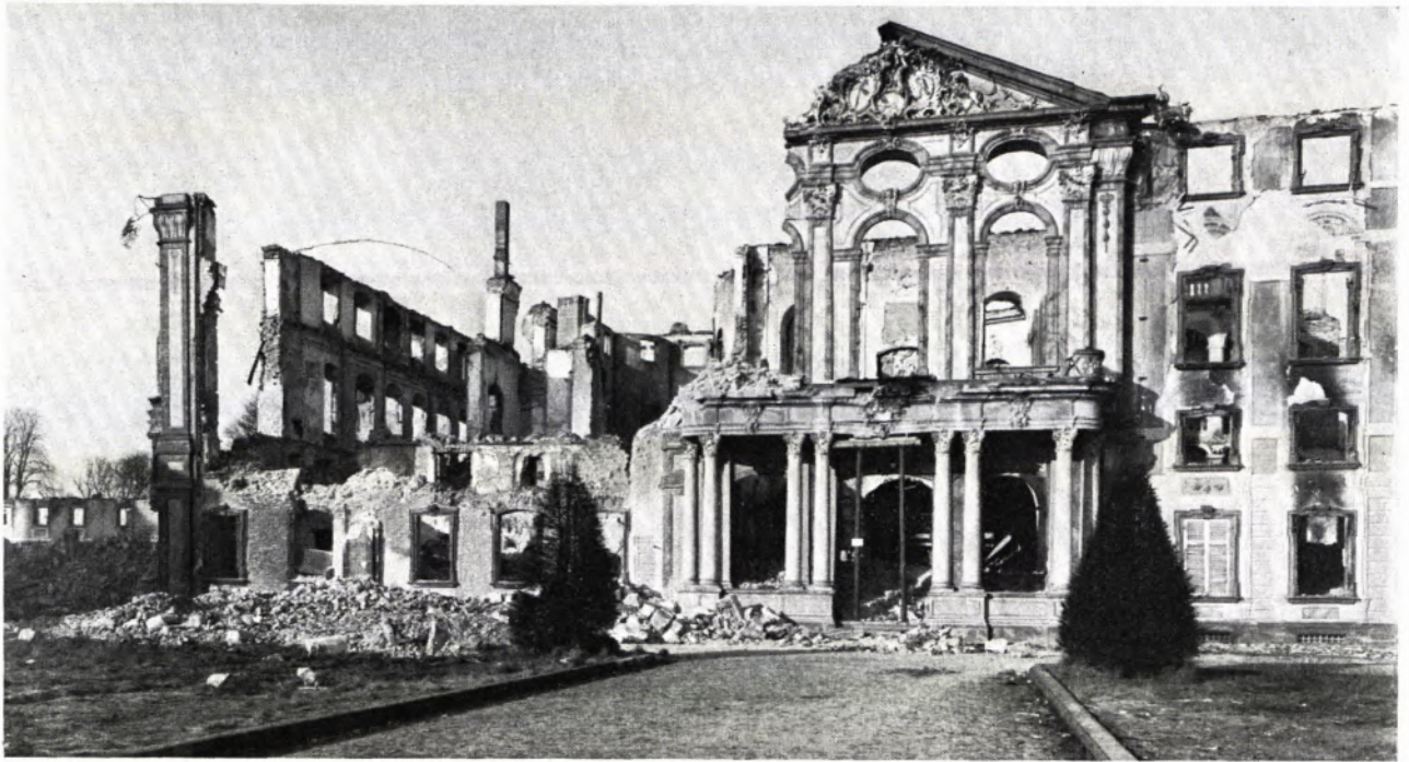
2 DAS CORPS DE LOGIS DES BRUCHSALER SCHLOSSES nach der Zerstörung durch den Luftangriff vom 1. März 1945.
