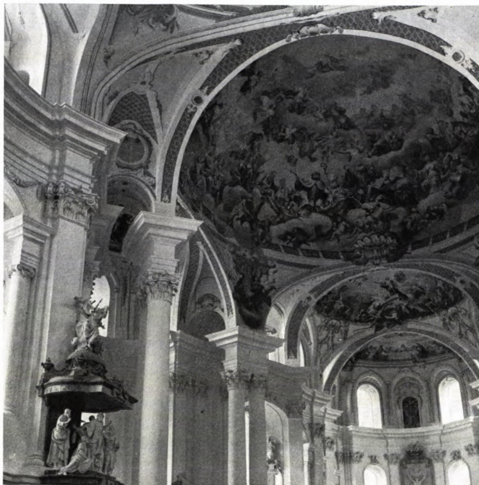
4 DIE RESTAURIERTE VIERUNGSKUPPEL – Deutlich erkennt man die von der Wand abgelöste Architektur des „Freistützen-Schalen-Baldachins“. Die übrigen Kuppeln sitzen auf den Außenwänden.
