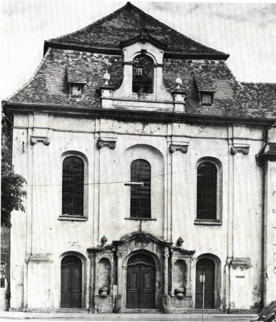
2 AUF DER NORDSEITE der Kirche sind die Wasser- schäden deutlich zu erkennen.
