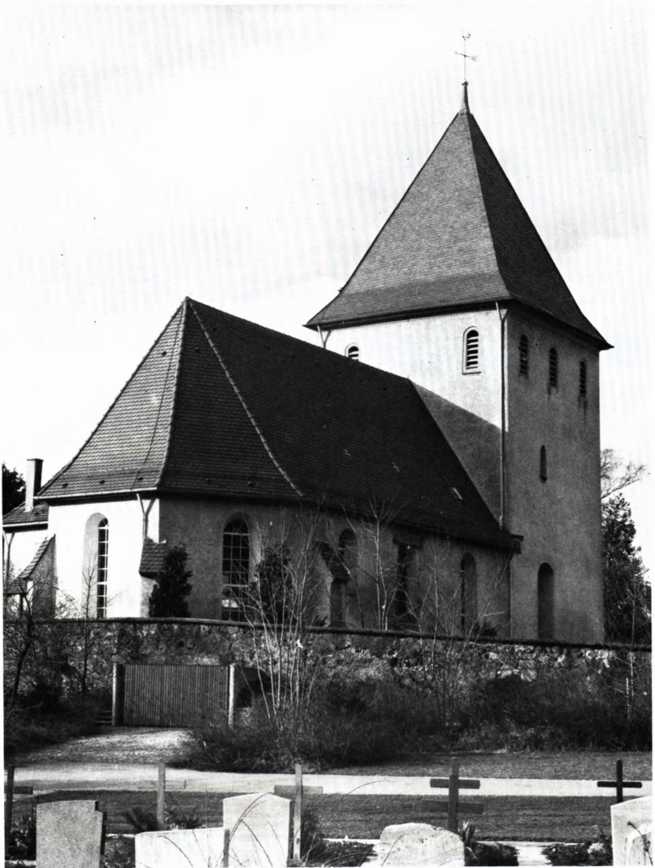
DIE MARTINSKIRCHE ZU GRUBINGEN VON NORDOSTEN. Das an sich bescheiden dimensionierte Bauwerk wird beherrscht von dem mächtigen, bollwerkartigen Westturm. Wie bei den jetzt durchgeführten Untersuchungen eindeutig nachzuweisen war, gehört er, der Nachfolger eines kleineren Vorgängers ist, ebenso wie die jetzt mit großen Fenstern des 18. Jahrhunderts durchlöchernten Sargmauern des Kirchenschiffes überwiegend dem 12. Jahrhundert zu. Das polygone Chorhaupt ist im 15. Jahrhundert an die Stelle einer im Halbkreis geführten romanischen Apsis getreten (vgl. Abb. Seite 17 oben).
